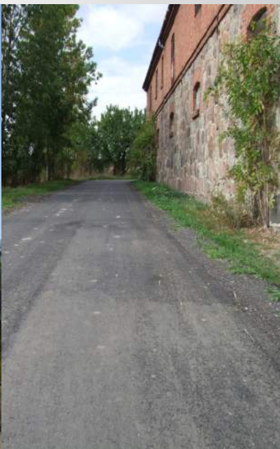
Wyremontowany odcinek drogi w Dochowej.
