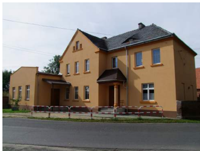
Wyremontowana elewacja świetlicy w Cieszkowicach. Koszt całej inwestycji to 33 239,40 zł. Dofinansowanie w ramach Programu Rozwoju Obszarów Wiejskich: 21 619,12 zł.
